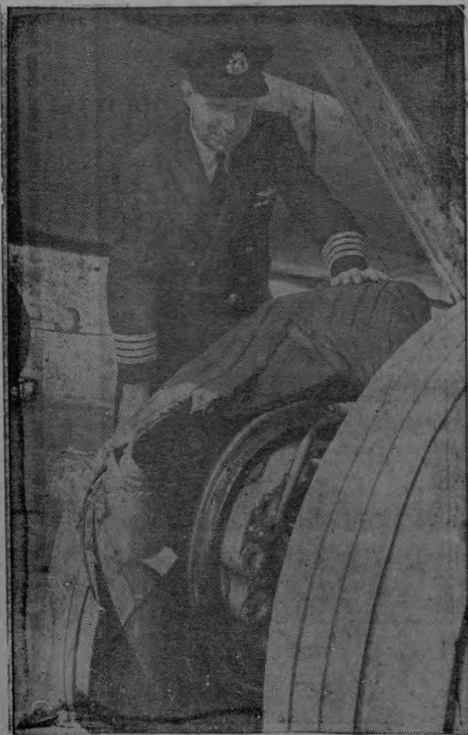
ATERRIZA CON UNA LLANTA PONCHADA. — El Capitán John Jones, piloto de una nave jet BOAC que aterrizó sanamente con una llanta ponchada, examina la llanta destruida en el aeropuerto Internacional Kennedy en Nueva York. La llanta, en un tren de aterrizaje de 8 ruedas explotó al despegar de Prestwick, Escocia, con 98 personas a bordo.
